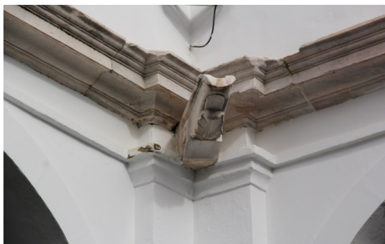
Figura 10 – Carlos Filipe. CECHAP-PHIM: mármore, cornija arquitravada e gárgula de despejo de águas pluviais (2023).
