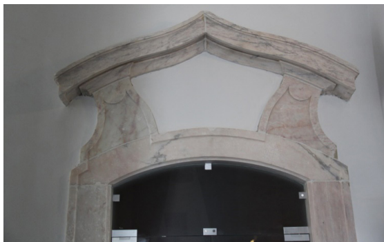
Figura 9 – Carlos Filipe. CECHAP-PHIM: mármore, emolduramento de porta com verga abatida e duplo frontão angular, bandeira recortado (2023).
