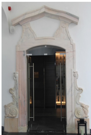
Figura 7 – Carlos Filipe. CECHAP-PHIM: mármore, emolduramento de porta do claustro com verga abatida e duplo frontão angular, bandeira recortado, nos laterais, ornatos com elementos de cartela vegetalistas, torçal, escamas adossadas às ombreiras (2023).
