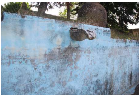
Figura 23 – Bica de mármore para abastecimento do tanque da cerca do extinto Convento de Nossa Senhora da Luz de Montes Claros. © 2023 | CECHAP | PHIM | JL
