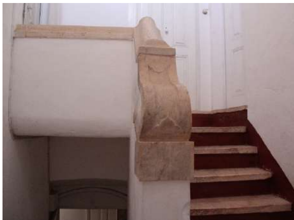
Figura 21 – Escadaria do extinto Convento de Nossa Senhora da Luz de Montes Claros. © 2020 | CECHAP | PHIM | CF
