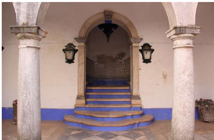
Figura 20 – Arco e escadaria do claustro do extinto Convento de Nossa Senhora da Luz de Montes Claros. © 2020 | CECHAP | PHIM | CF
