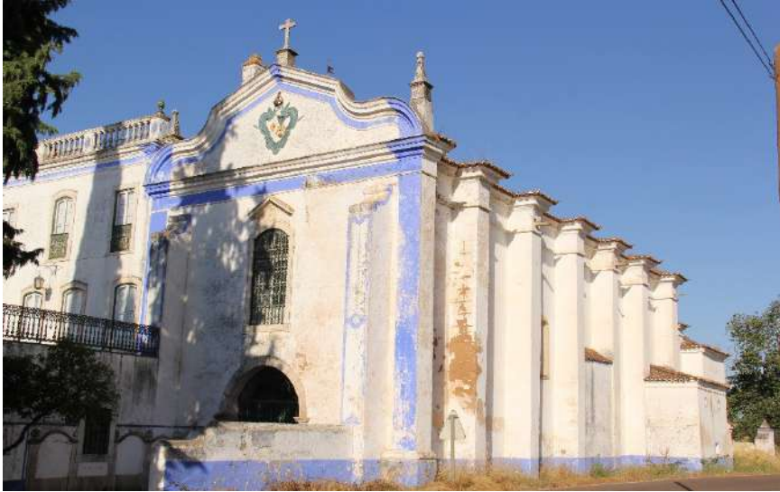
Figura 1 – Igreja do extinto Convento de Nossa Senhora da Luz de Borba.
